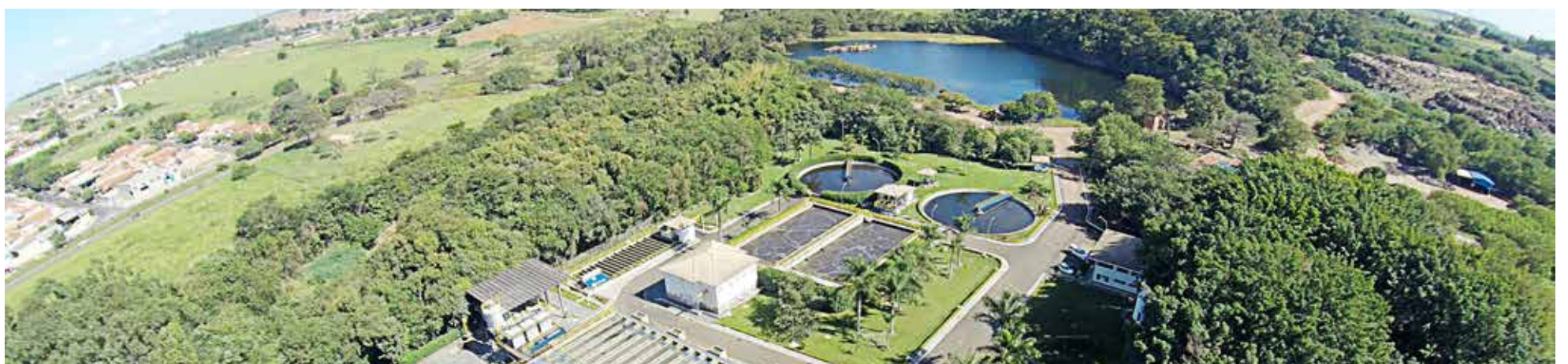
Vista aérea da ETE
