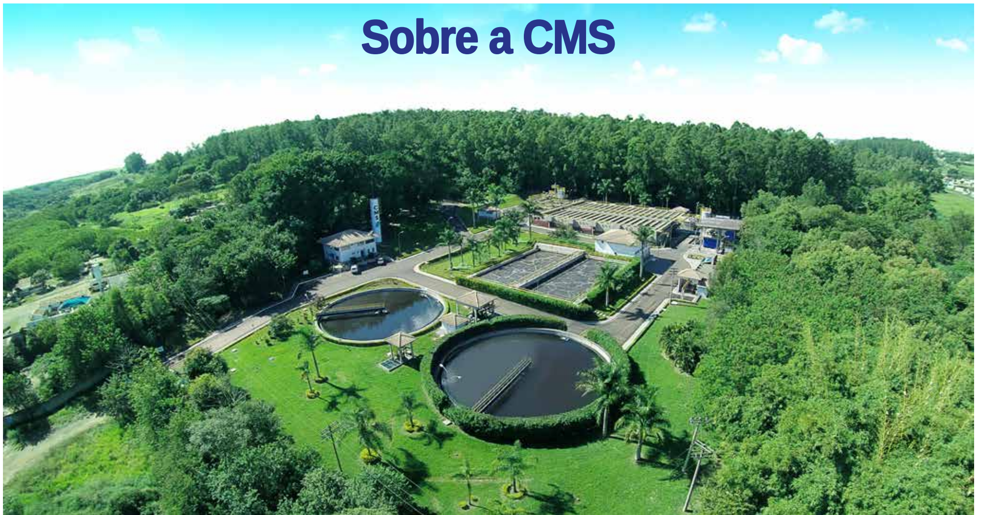
CMS opera desde 2005 tratando o esgoto doméstico de Matão numa área de 25 mil metros quadrados, capaz de atender uma população de até 110 mil habitantes
