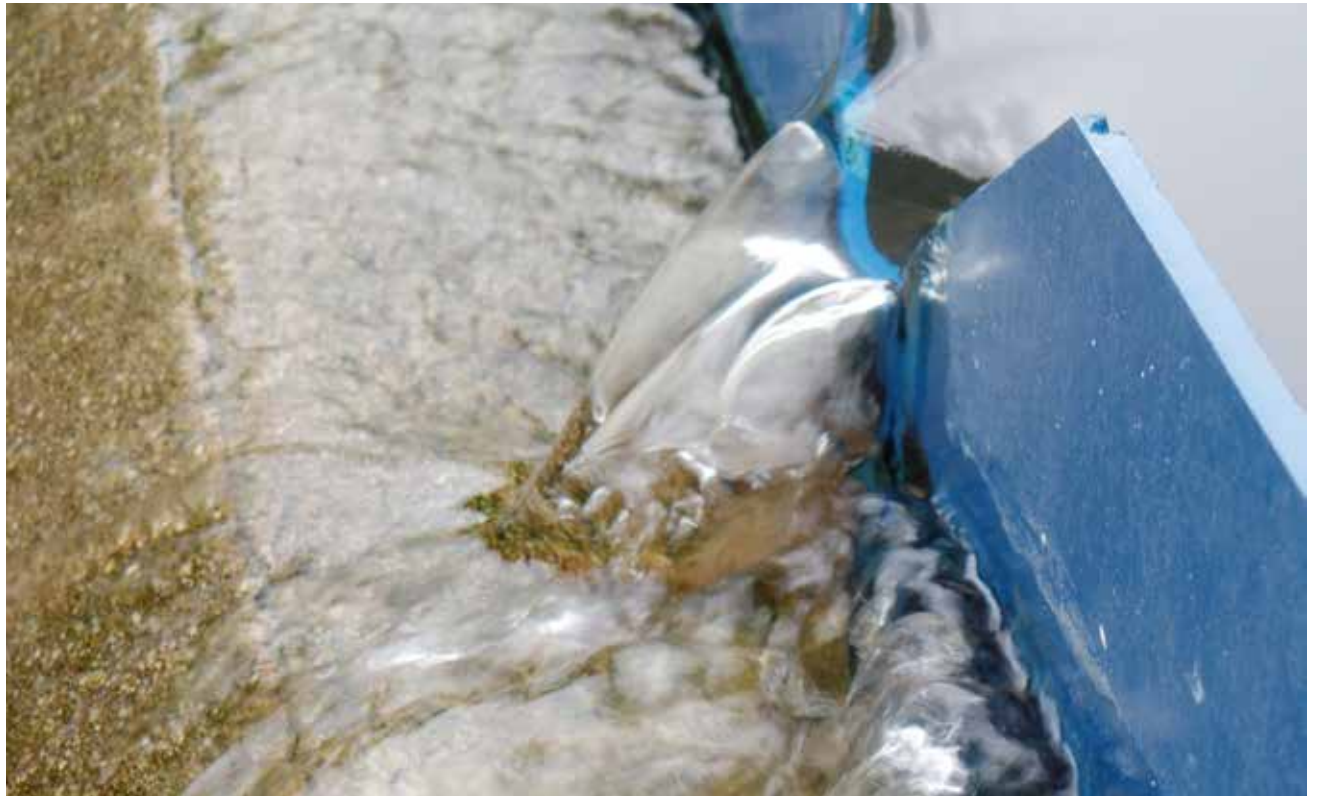
Após o tratamento, esgoto é direcionado ao rio São Lourenço como água cristalina
