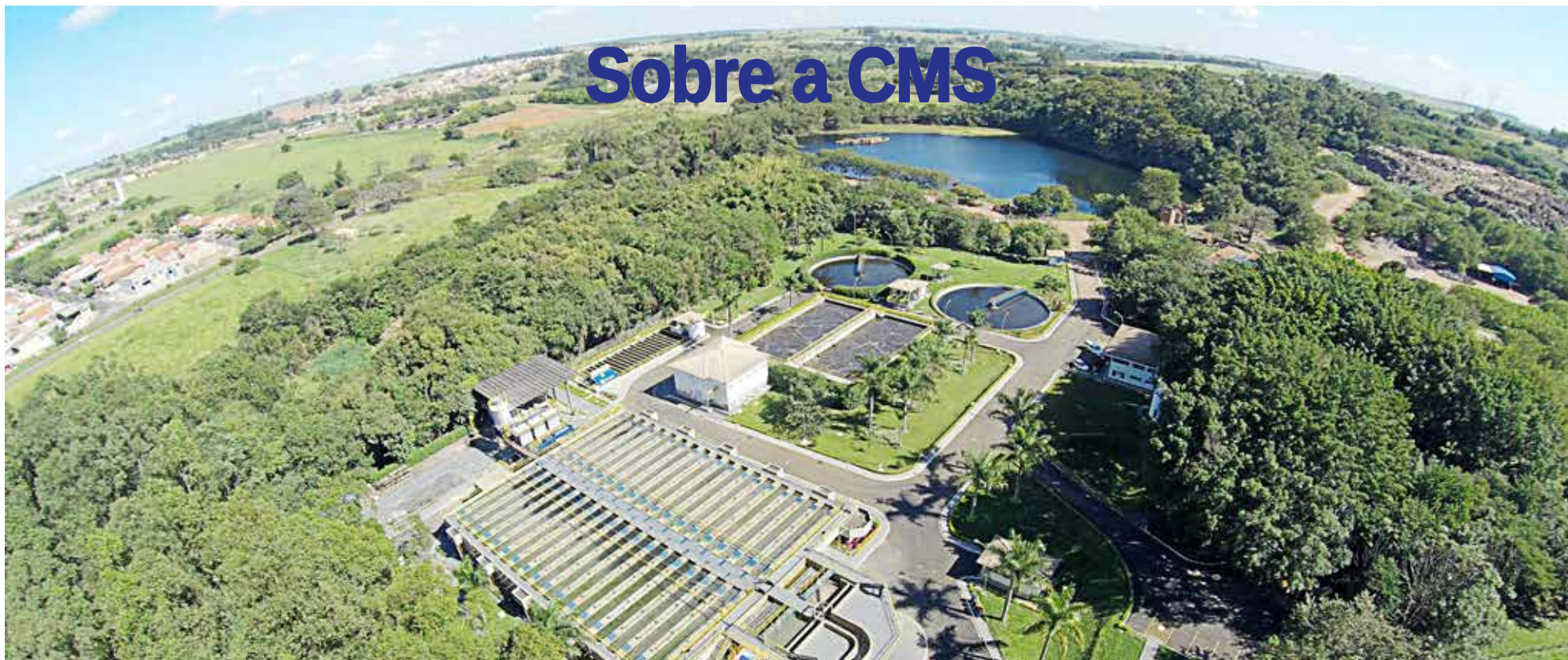
Vista aérea da ETE
