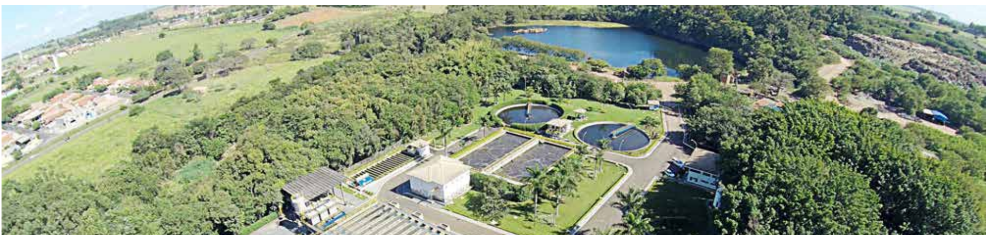
Vista aérea da ETE
